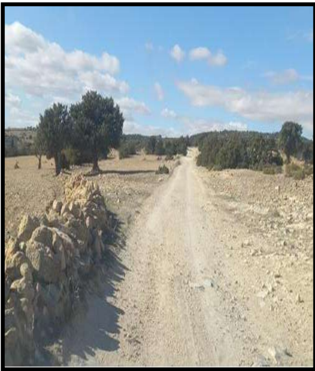
Figure 22: chaussé en en terre battue
