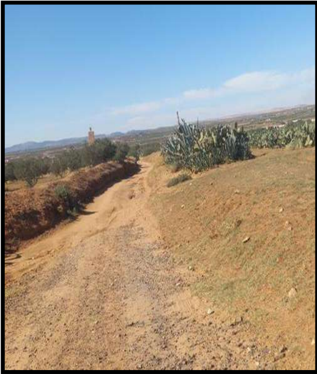
Figure 21: couche de base dégradée
