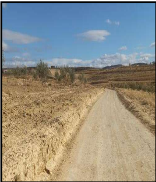
Figure 20: chaussé en en terre battue
