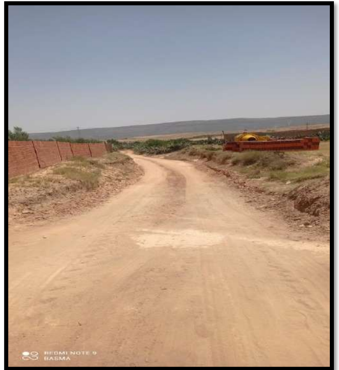
Figure 19: chaussé en en terre battue
