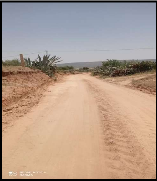
Figure 19: chaussé en en terre battue
