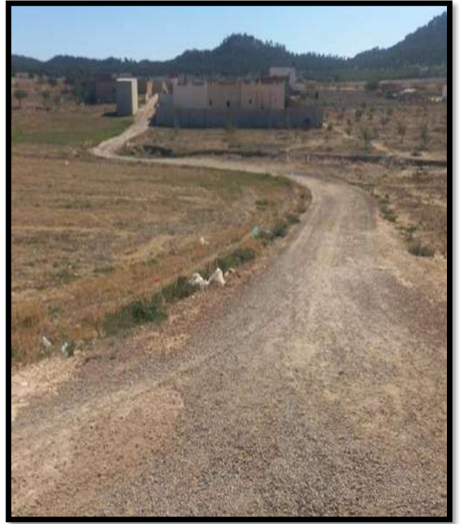
Figure 21: couche de base dégradée
