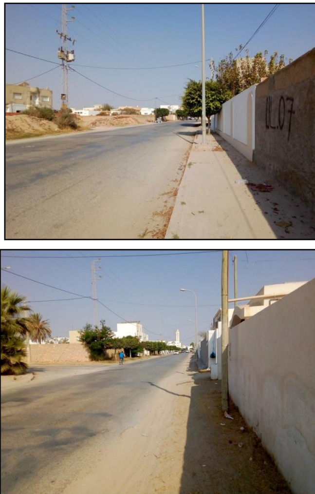
Figure 8: L'état de la chaussée
