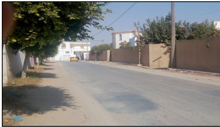
Figure 9: Chaussée dégradée
