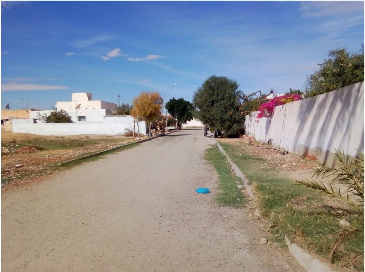
Etat actuel de la voie n°1
