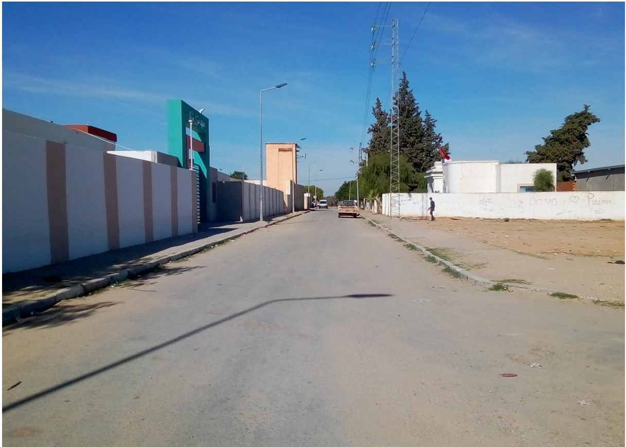
Etat actuel de la voie n°6
