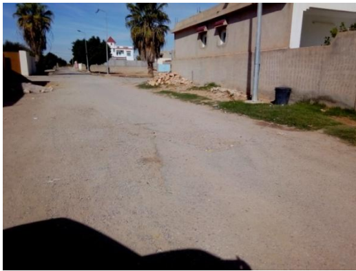
Figure 10: Chaussée dégradée
