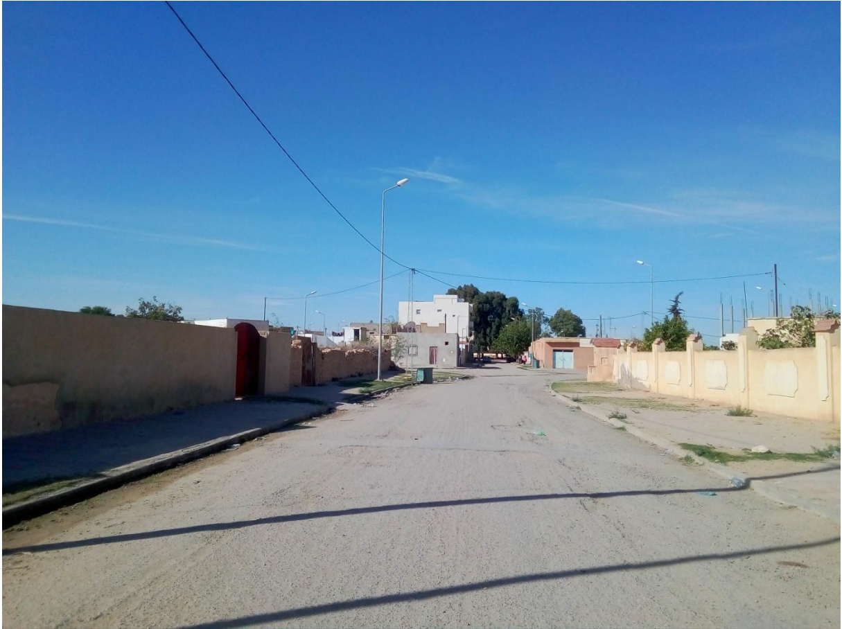
Etat actuel de la voie n°13
