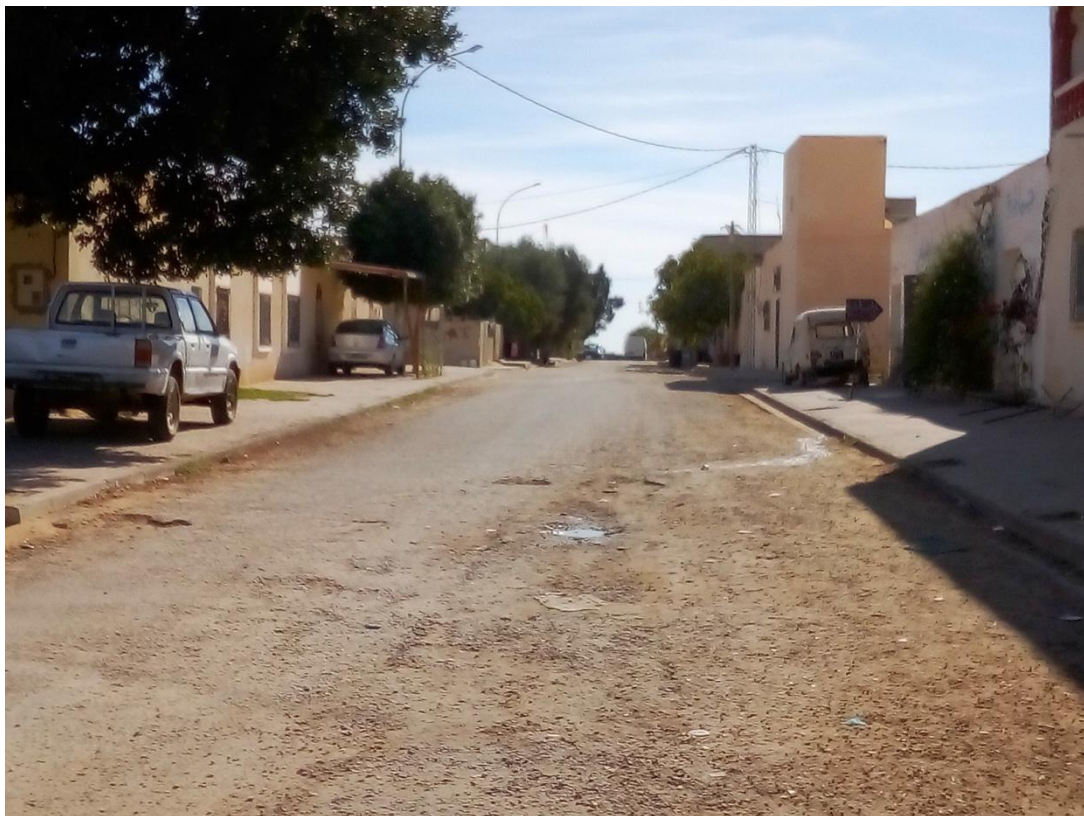
Etat actuel de la voie n°10
