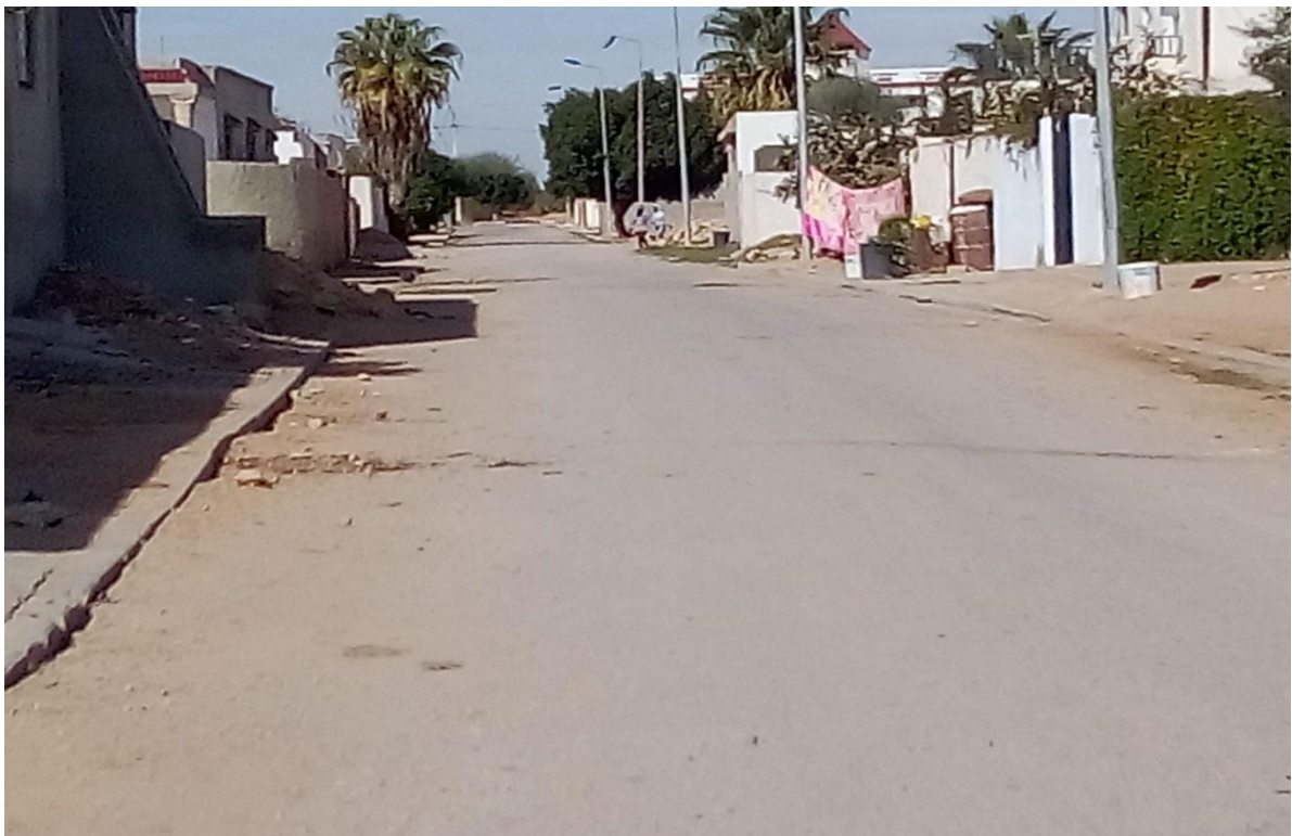
Etat actuel de la voie n°5
