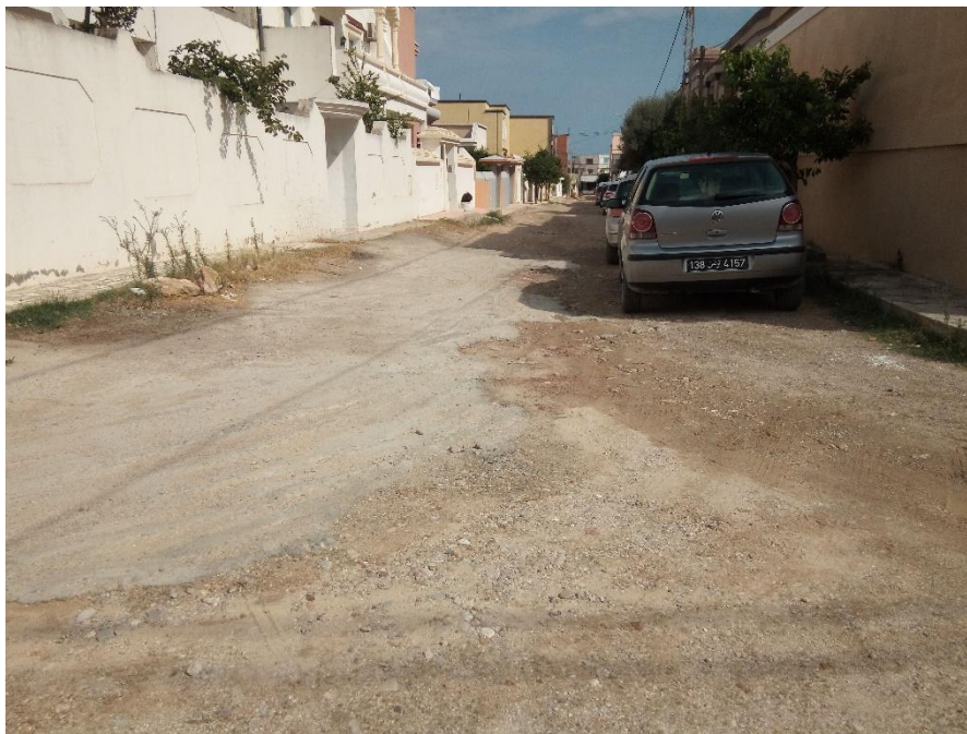
Figure 17 : photo de la rue Imem Boukhari
