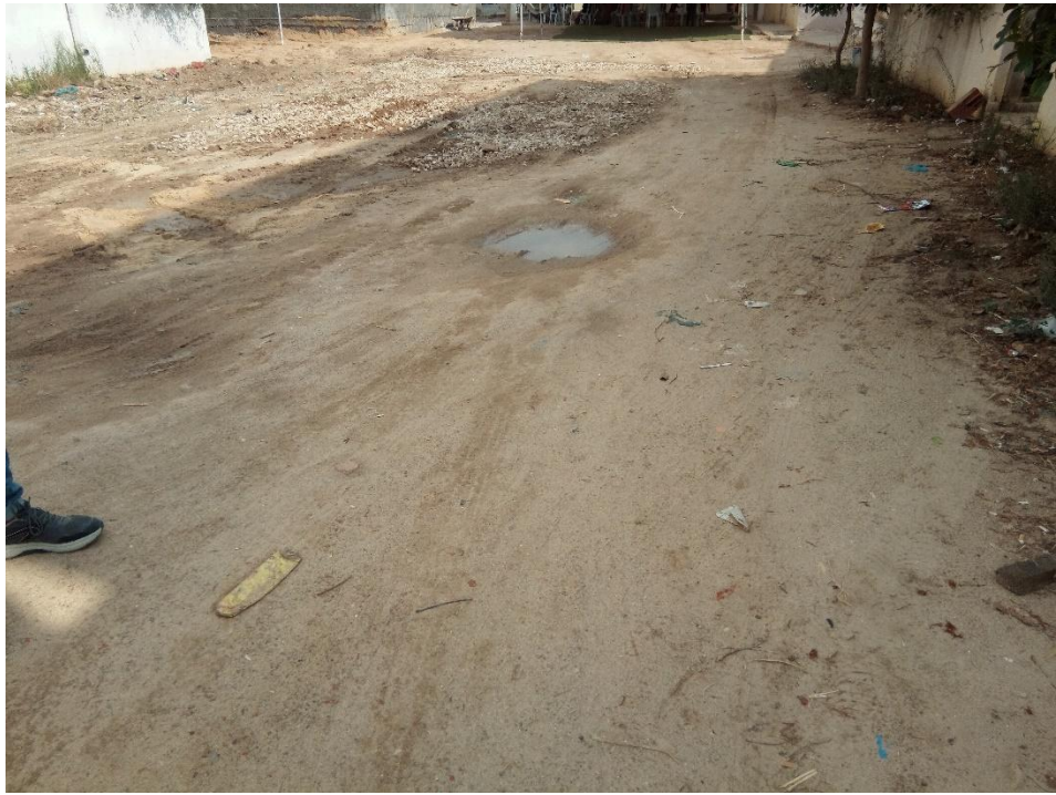
Figure 30: photo de la rue AbdErahmen Ibn Aouf
