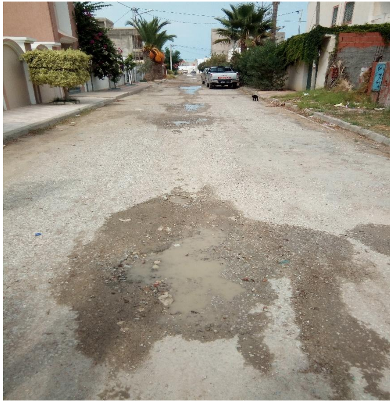
Figure 20 : photo de la rue Baies
