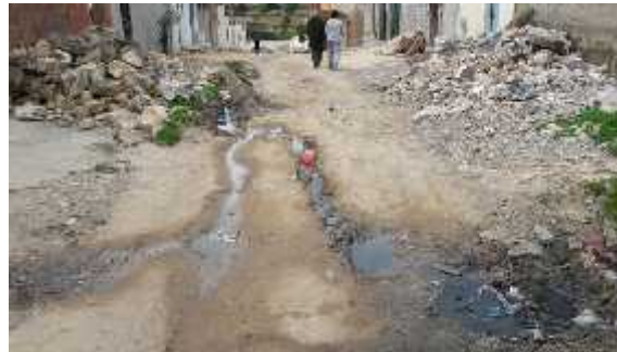
Figure 4: dégagement aléatoire des eaux usées domestiques au niveau des voies
