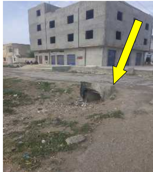
Figure 7: Colmatage des dalots et des canaux de drainage des eaux pluviales en bas du quartier
