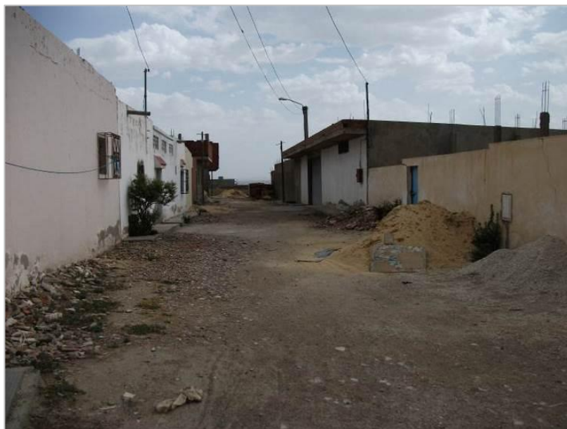
Figure 7: Voie en terre en état médiocre
