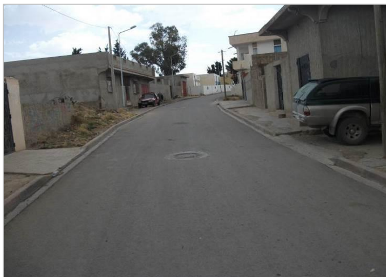
Figure 5: La voie V1 en enrobée
