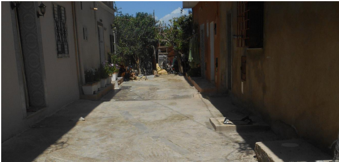
Regards à grilles assurant le raccordement avec le réseau ONAS (Voie 8 du quartier Boucif)
