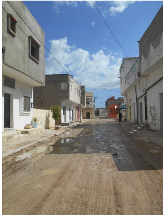
Figure 6-7: Stagnation des eaux pluviales et de la boue dans la zone Ben Taeib du quartier d'Echrifet
