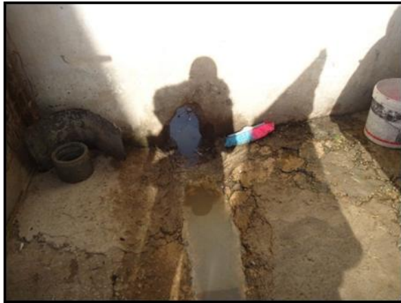
Ouverture dans un mur (Voie 2 du zone Boucif)
