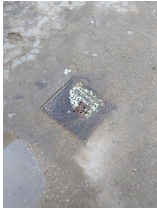
Des trous pour raccorder avec le réseau ONAS (Voie 9 du quartier Ben Taieb)
