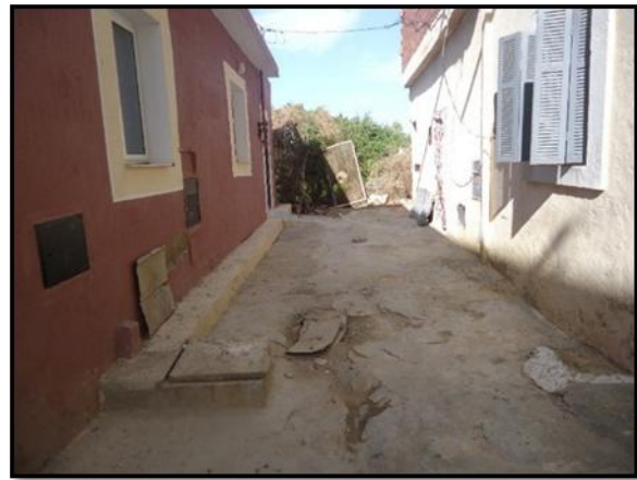
Eaux évacuées vers une parcelle agricole (Voie 4 du zone Boucif)
