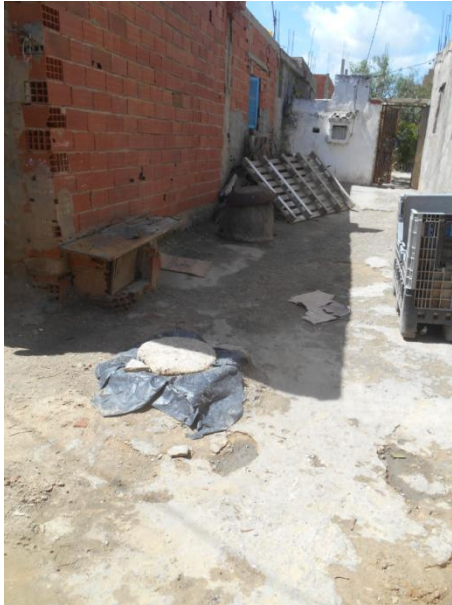
Regards à grilles assurant le raccordement avec le réseau ONAS (voie 3 du zone Bousif)
