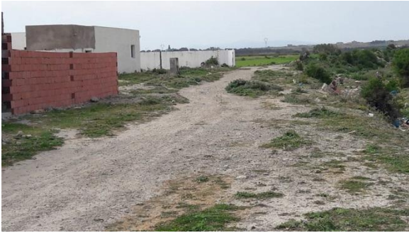
Station de pompage ONAS au niveau de V1
