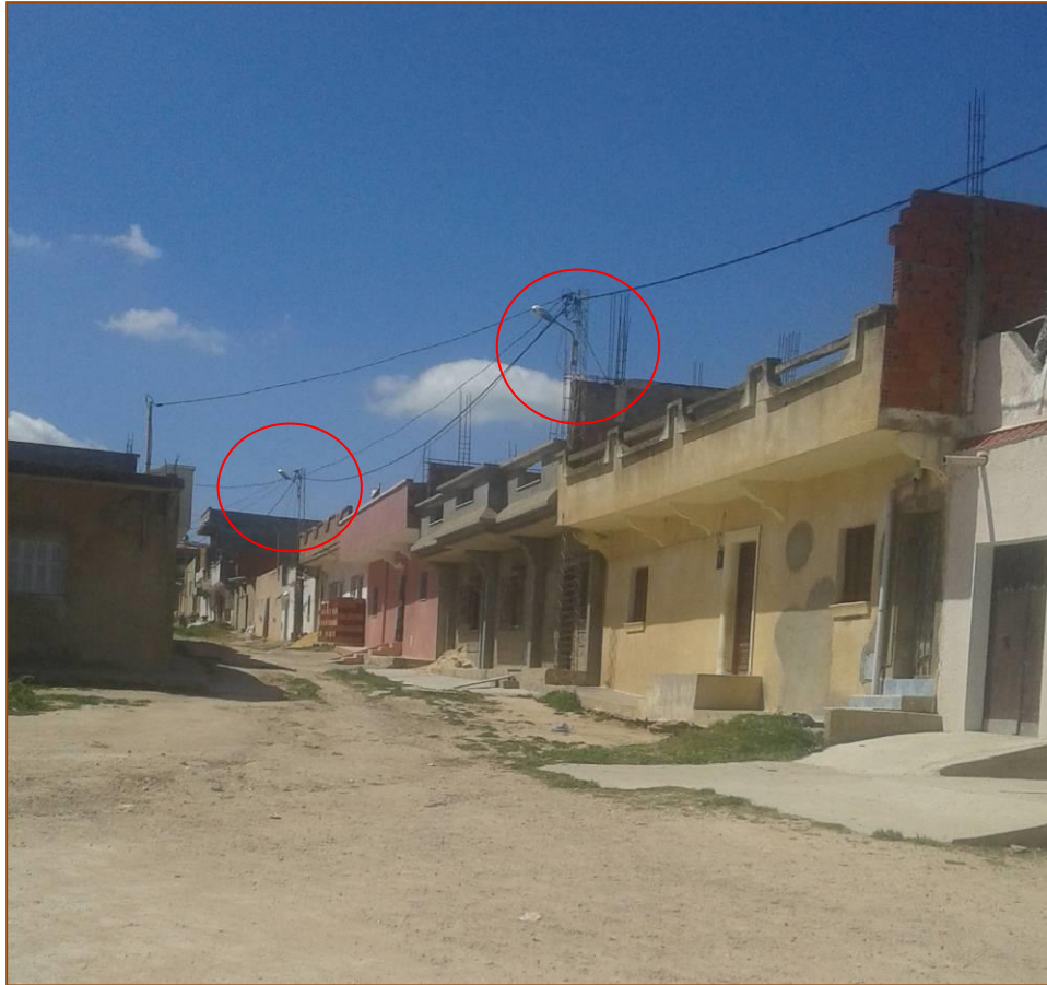
Photo 4 : Éclairage public au quartier Ras Ain.
